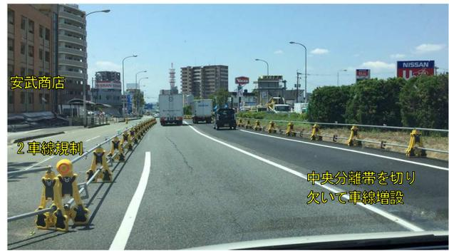
図-28 中央分離帯を切り欠いて車線を確保した事例
